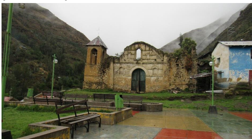
Figura 136: Frontis de la Iglesia de la virgen de Sillapata y la plaza principal de Ayahuanco 2023
