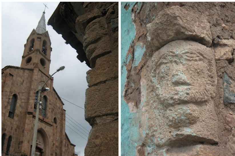
Figura 50: Imagen de Ccoto Pichi vista lateral al fondo el Convento
