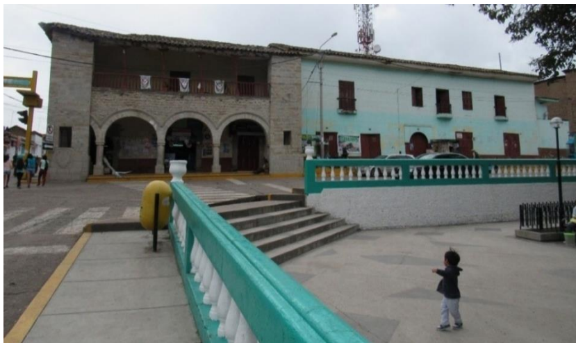
Figura 57: Casona y Portal Iguain actual con tres arcos.
