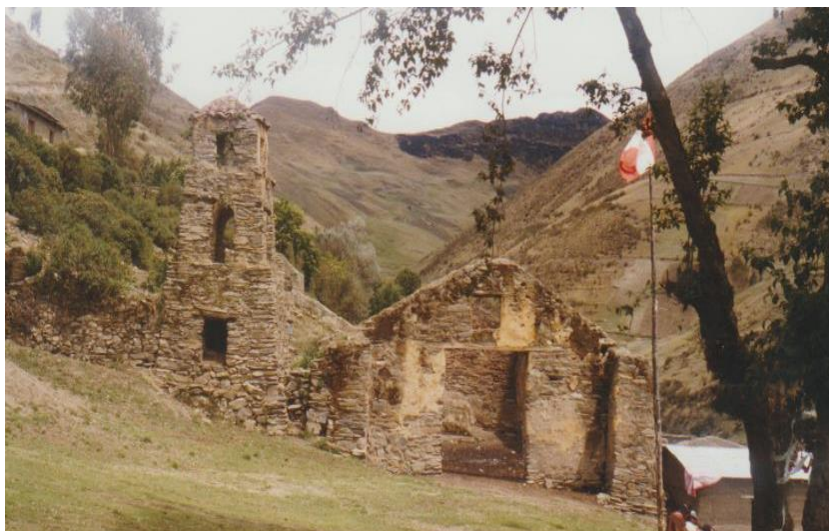
Figura 76: Iglesia derruida de San José de Iquicha - 2002
