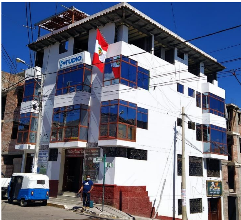
Figura 65: Edificio de la familia Sánchez 2021
